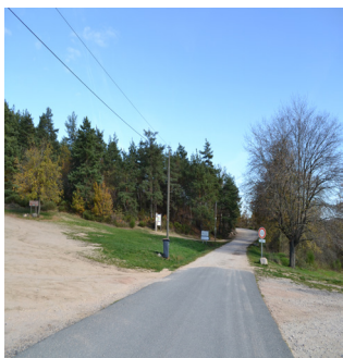
Chemin d'accès piétonnier
